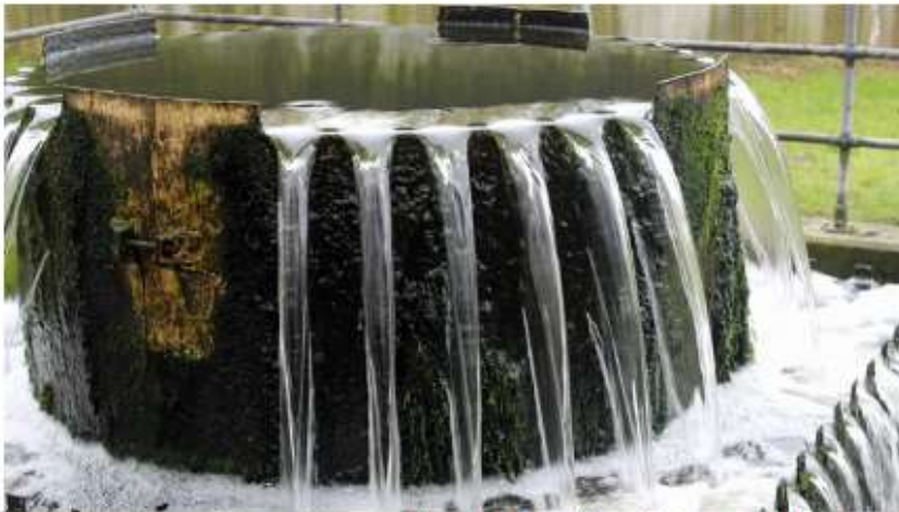
Rensningsanlæggene fanger det meste mikroplast fra spildevand. Her ses en iltningstrappe ved Nivå Rensningsanlæg.
